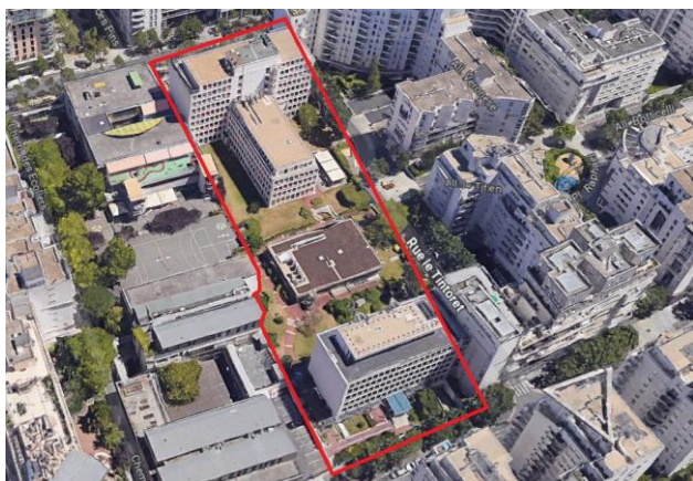
Photo de l'existant
